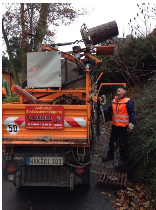
Mit moderner Technik waren die beauftragten Spezialfirmen unterwegs. Im zweiten Durchlauf im Herbst 2015 reinigten sie schon bis zu 150 Straßeneinläufe am Tag.
